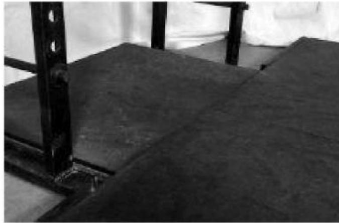
*Рисунок 8-7. Пол внутри силовой рамы должен быть выполнен заподлицо с поверхностью помоста с тем расчетом, чтобы процесс снятия и возврата штанги на упоры, когда тренирующийся приседает снаружи рамы, был полностью безопасным.*
